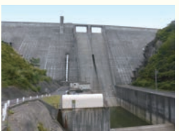
10 破間川ダム 重力式コンクリートダムで、洪水調節・不特定利水・水力発電を目的としています。 〈営業期間〉5月～12月の平日9:30～16:00
